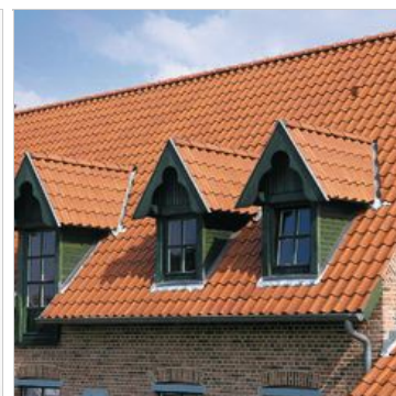
Dach - "piąta elewacja"
