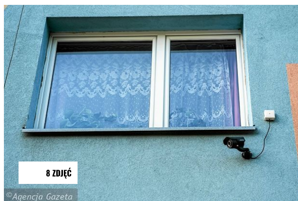
Kamera na budynku przy ul. Zielińskiego TOMASZ PIETRZYK
