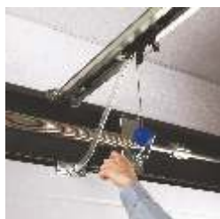
Szyna prowadząca z paskiem napędowym
